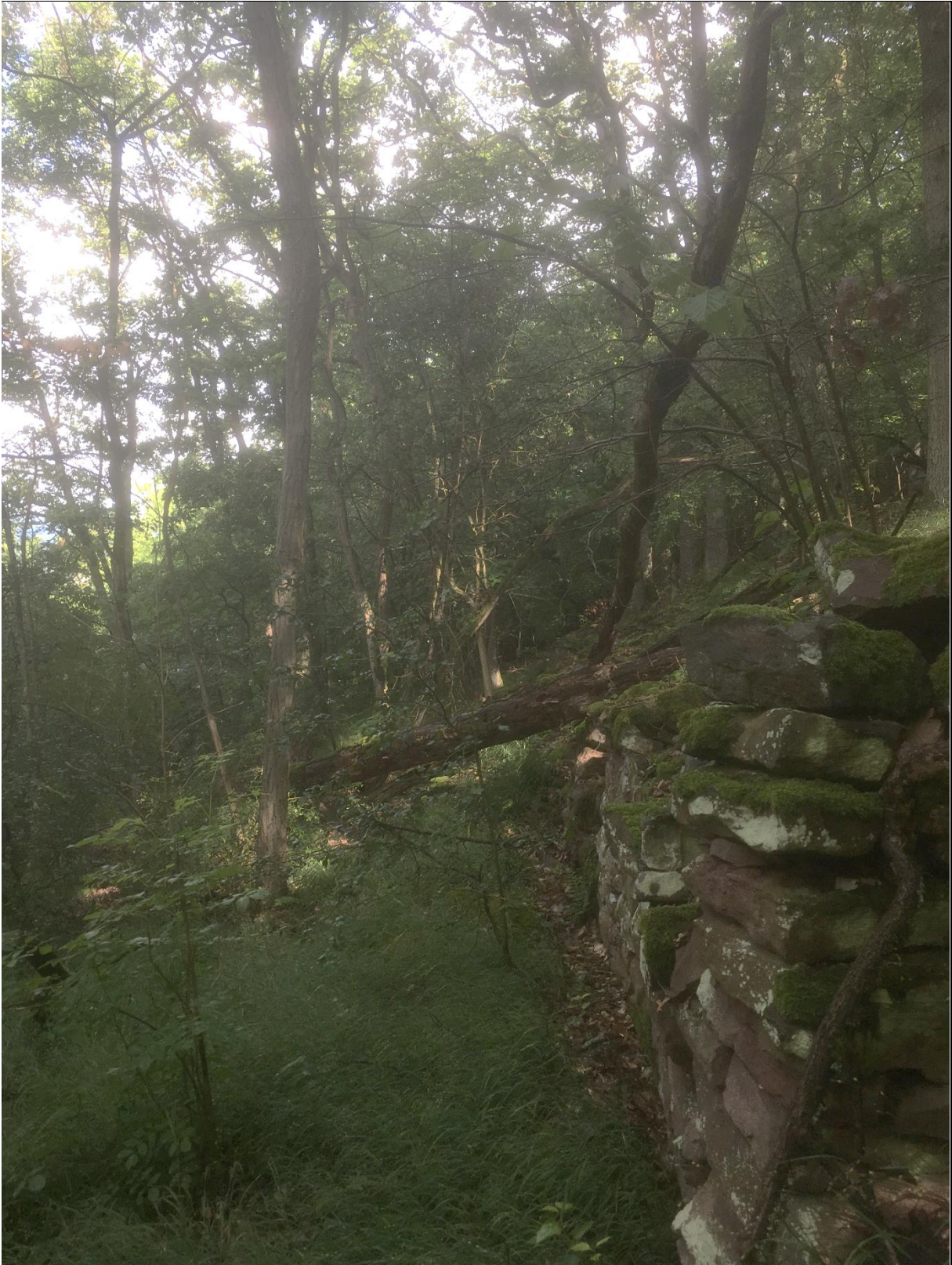
Abb. 18: LRT 9170 auf ehemaligen Wein- oder Obstbauterrassen (Foto: J. Erben)
